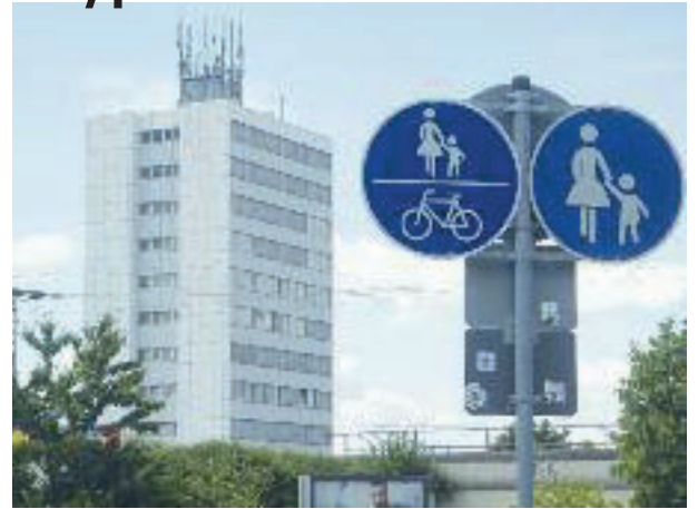
Ein Hochhaus voller Antennen, deren Funkwellen auch den Stadtteil Vauban 'abdecken' Foto R. Schepers
